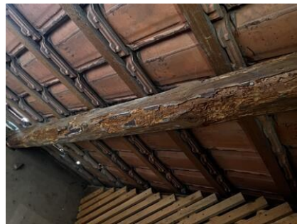
Überwachung von Fachwerken
