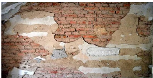
Monitoring feuchter Ziegelwand
